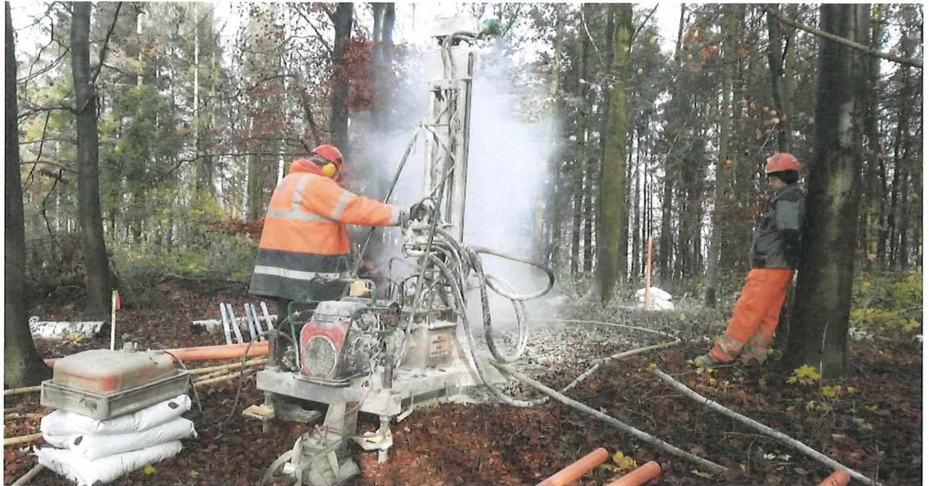
Abbildung 12: Bohren mit dem Bohrgerät EMCI Explor 220MPR.
