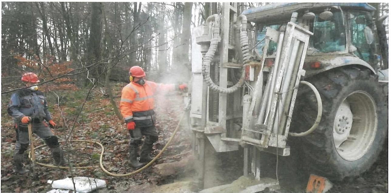
Abbildung 11: Bohren mit dem Bohrgerät PAT-301.
